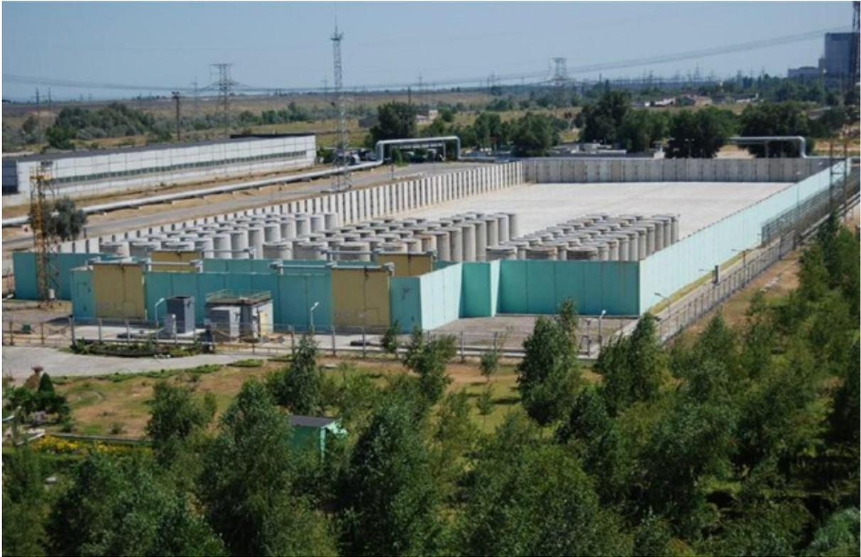
***Installation de stockage à sec sur le site de Zaporizhzhia avec fûts de stockage à sec en béton***
